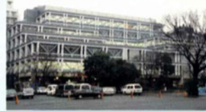
●外部露出仕様・耐火仕様 円形鋼管仕様・溶接接合仕様 1991年 アイ・ケイ・ビル(東京都) 設計: (株) 日建設計
