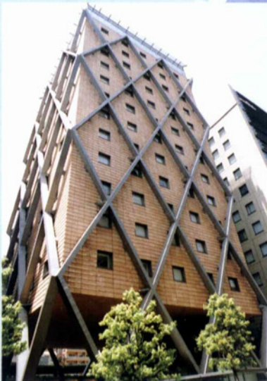
●外部露出仕様・矩形鋼管仕様 累積変形記録装置設置 1997年 (株) SANKYO 新東京本社ビル(東京都) 設計: (株) プランテック総合計画事務所 / (株) アルファ構造事務所
