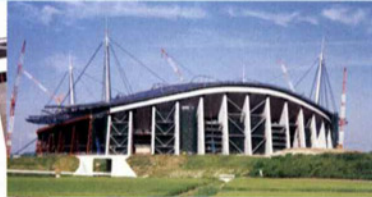
●制振タイプ (BT-LYP100) 鋳鋼+ピン接合仕様 2000年 豊田市スタジアム 設計: 黒川紀章建築都市設計事務所 / アラップ ジャパン
