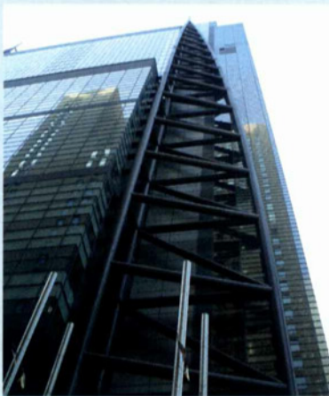
●外部露出仕様・円形鋼管仕様 バットレス構成制振部材 2003年 日本テレビタワー(東京都) 設計: (株) 三菱地所設計 ・リチャードロジャースパートナーシップ (基本構想デザイン協力)
