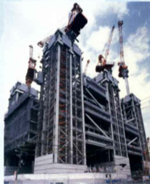
●制振タイプ (BT-LYP100) 鋳鋼+ピン接合仕様 2000年 豊田市スタジアム 設計: 黒川紀章建築都市設計事務所 / アラップ ジャパン
