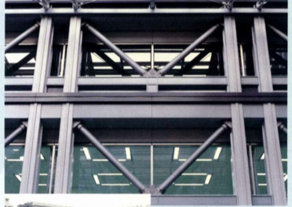
●外部露出仕様・耐火仕様 円形鋼管仕様・溶接接合仕様 1991年 アイ・ケイ・ビル(東京都) 設計: (株) 日建設計
